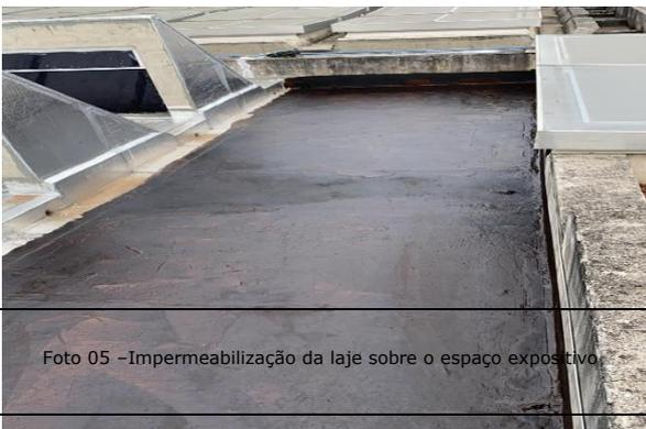
Foto 05 – Impermeabilização da laje sobre o espaço expositivo
