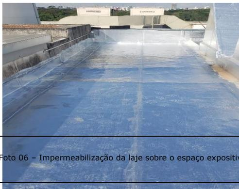
Foto 06 – Impermeabilização da laje sobre o espaço expositivo
