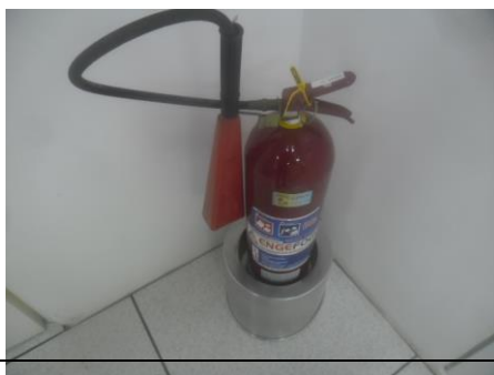
Foto 01 - Inspeção dos extintores
