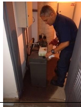
Foto 02 – Manutenção preventiva dos elevadores
