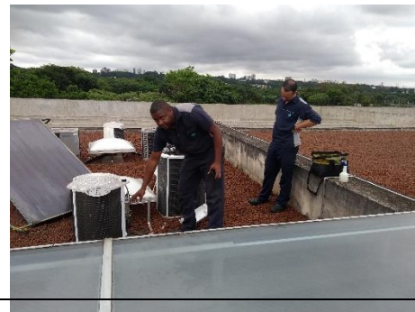
Foto 04 – Manutenção preventiva do ar condicionado
