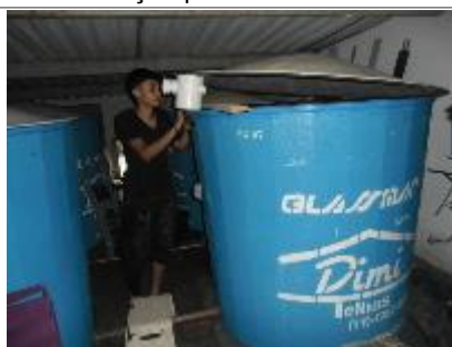
Foto 7 – Impermeabilização de 2 caixas d'agua
