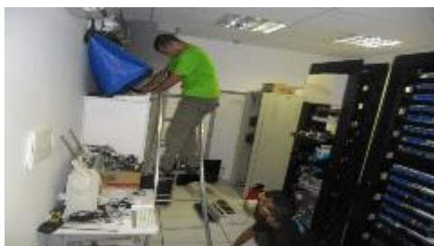
Foto 5 – Manutenção preventiva do ar condicionado
