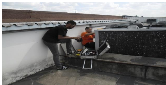
Foto 05 – Manutenção preventiva do ar condicionado
