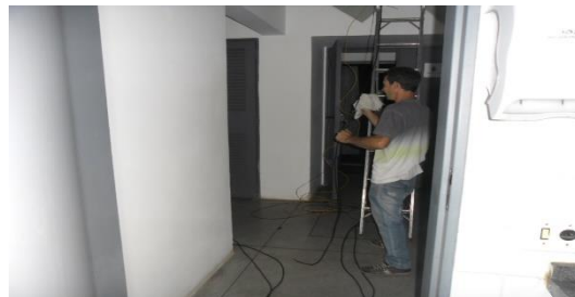
Foto 06 – Instalação da bomba do hidrante
