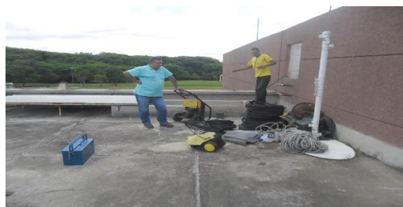
Foto 02 – Lavagem da fachada
