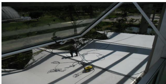
Foto 06 – Limpeza da cobertura do deck
