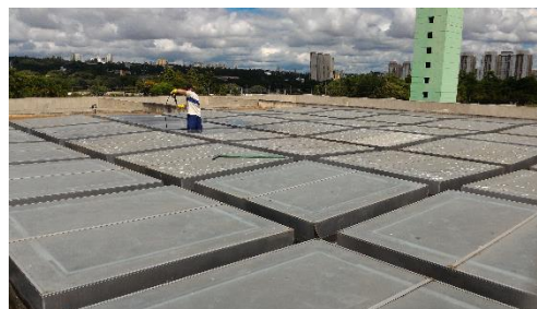
Foto 07 – Limpeza do domus da cobertura
