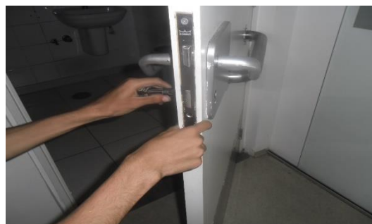
Foto 04 – Fixação das chaves na porta do banheiro deficiente
