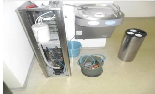
Foto 02 – TROCA DO REFIL DOS FILTROS DOS BEBEDOUROS
