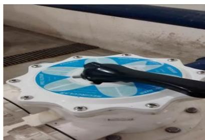
Foto 03 - TROCA DA TAMPA DO FILTRO DO ESPELHO D'ÁGUA
