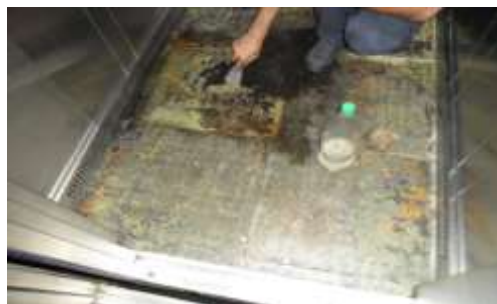
Foto 01 – REFORMA DO PISO DO ELEVADOR LD DIREITO
