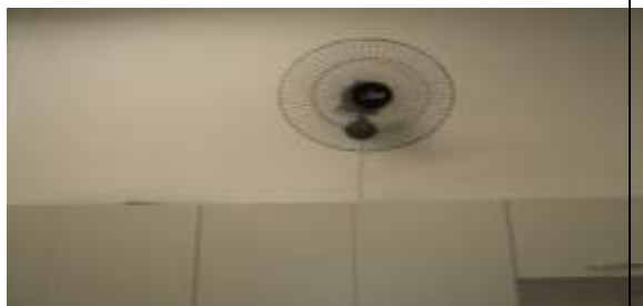
Foto 01 – TROCA DO VENTILADOR DA COPA
