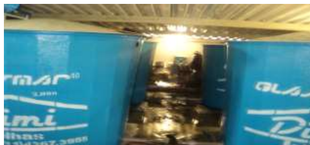
Foto 04 –LAVAGEM DAS CAIXAS D'AGUA
