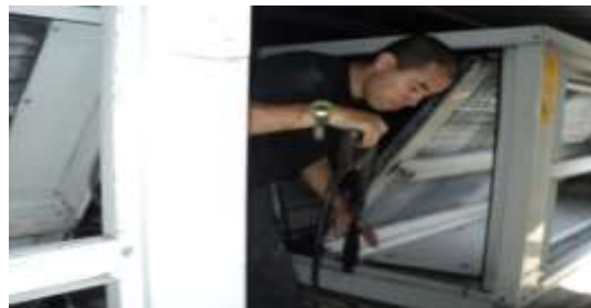
Foto 06 – MANUTENÇÃO PREVENTIVA MENSAL DO AR CONDICIONADO
