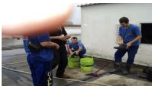
Foto 05 –LAVAGEM DAS CAIXAS D'AGUA
