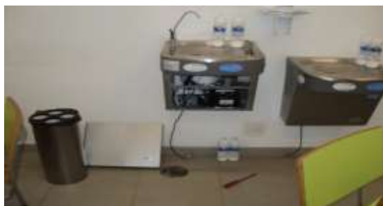
Foto 03 –TROCA DO REFIL DOS FILTROS DOS 06 BEBEDOUROS
