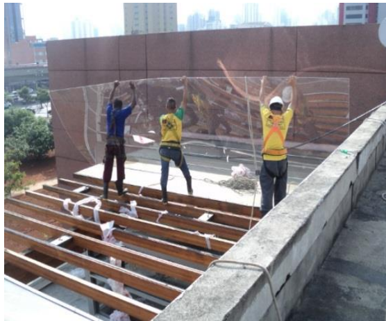
Troca de duas placas de policarbonato OS nº 2399
