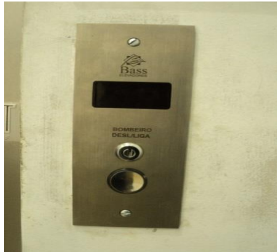
Instalação da botoeira do bombeiro. OS nº 2305
