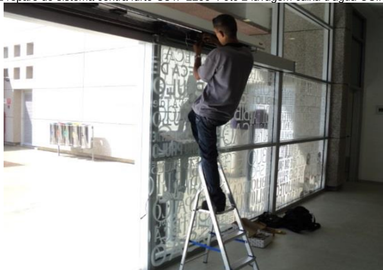
Reparo Porta Automática Dorma OS nº 2387
