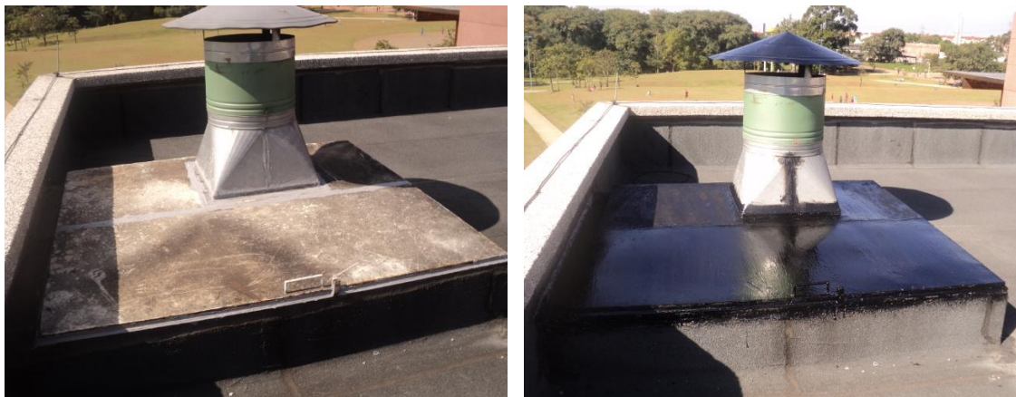
Fotos da instalação do banner OS nº1711 e OS nº1717 Manutenção do tampão da sala técnica
