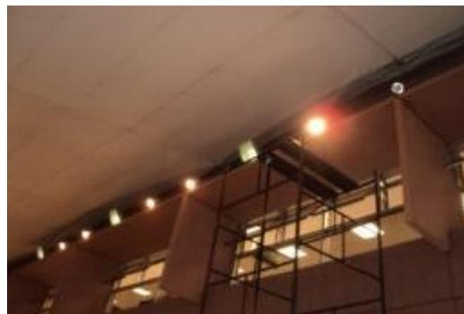
**Fotos:** Trocas de lâmpadas do terraço da lona tensionada, com utilização de andaime. OS nº935
