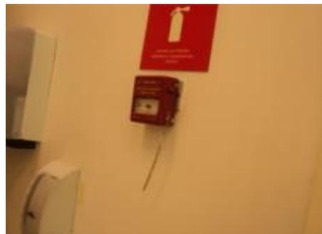
**Fotos:** Caixas de alarme com o martelo reposto
