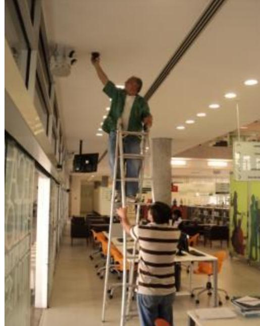
**Foto:** Reparo da quatro sensores de incêndio
